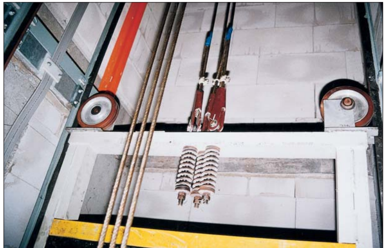
Gegengewicht mit Rollenführung Counterweight with roller guides Contrepoids avec coulisseaux à galets
